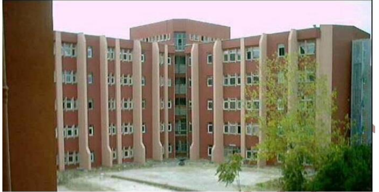
Betonarme Payandalar İle Dışardan Güçlendirme-İ.Ü-Mühendislik Fakültesi
