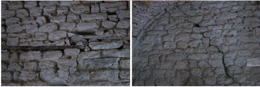
Sekil 84. B Duvar Yüzü, D Duvar Yüzü
